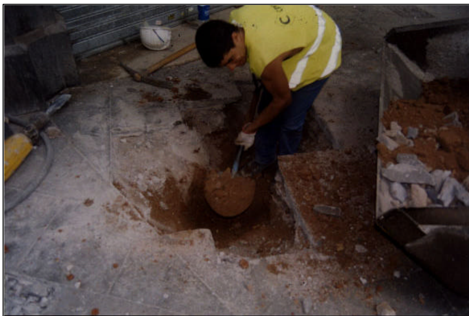
Il·lustració 5: Obrer treballant a la Cata 1. 018/03-6
