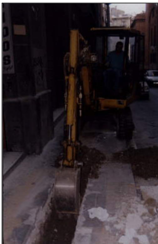
Il·lustració 7: Màquina treballant a la rasa 2- 018/03-16
